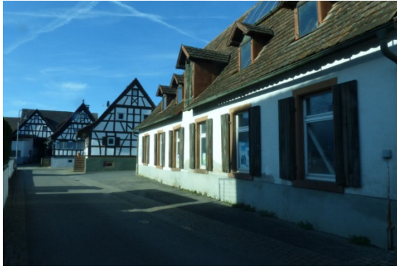
Heimstraße 8: Ansicht von Nordost
