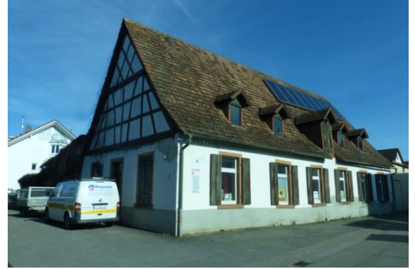
Heimstraße 8: Ansicht von Südwest
