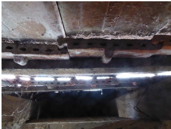
Abbildung 5: Einflugmöglichkeiten zum Dachstuhl zwischen Dachziegeln
