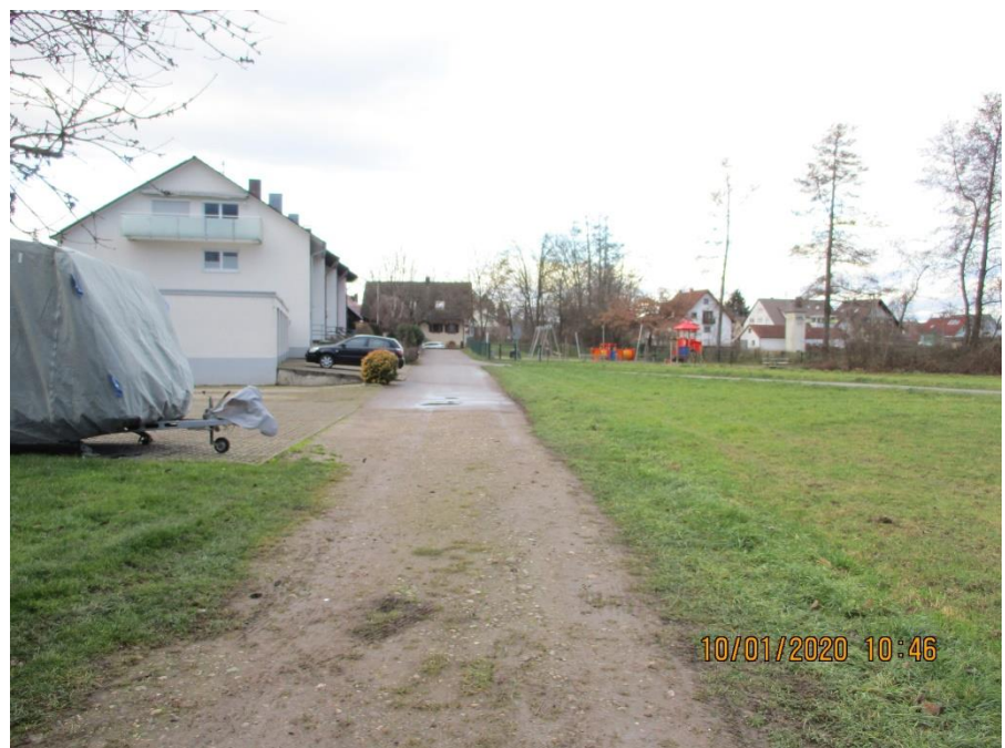
Foto 2: Planbereich 1: Hier geht das Wasser von einem offenen Graben in ein Rohr über
