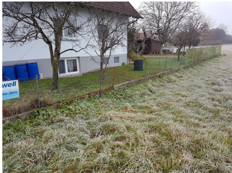
Foto 6: Mauer welche durch eine höhere ersetzt werden soll (Foto: Herr Krämer, BIT Ingenieure)
